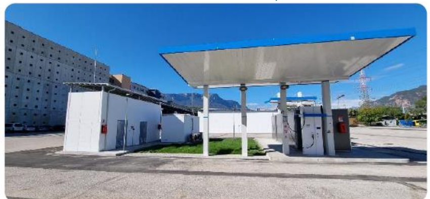
Wasserstofftankstelle in Bozen, Italien
