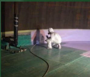
Einzel- & Doppelboden Sanierung
