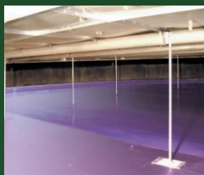
Einzel- & Doppelboden Sanierung
