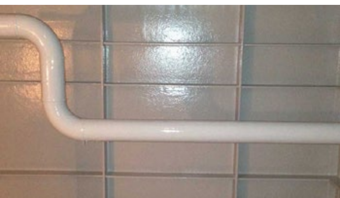
Saniertes Tank zur Wasserspeicherung.
