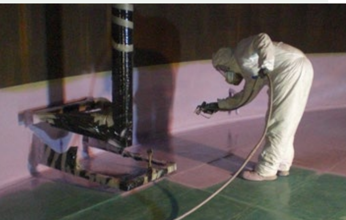
Anwendung des DOPA®-Systems durch Wolf tank-Techniker.
