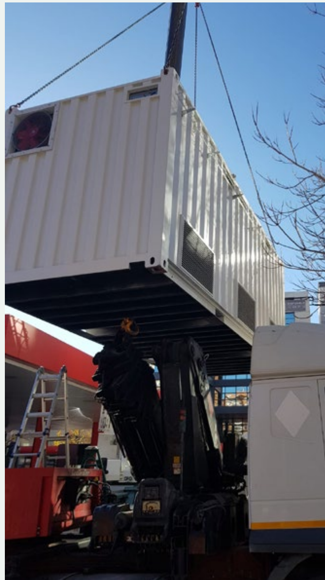
Installation einer Wasserstofftankstelle in Madrid, Spanien.
