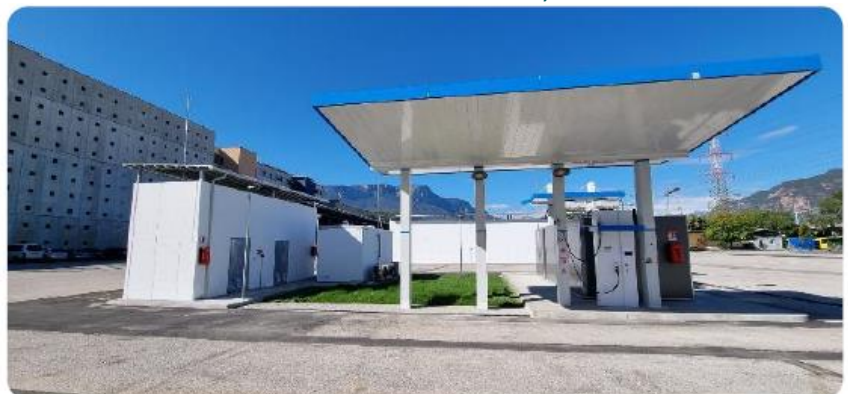
Wasserstofftankstelle in Bozen, Italien
