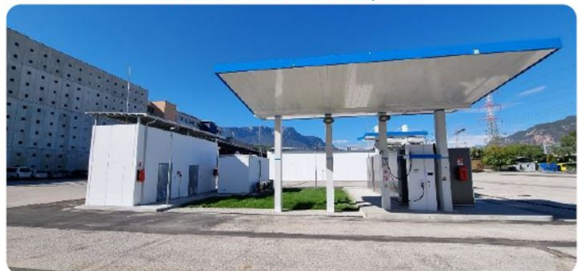
Wasserstofftankstelle in Bozen, Italien
