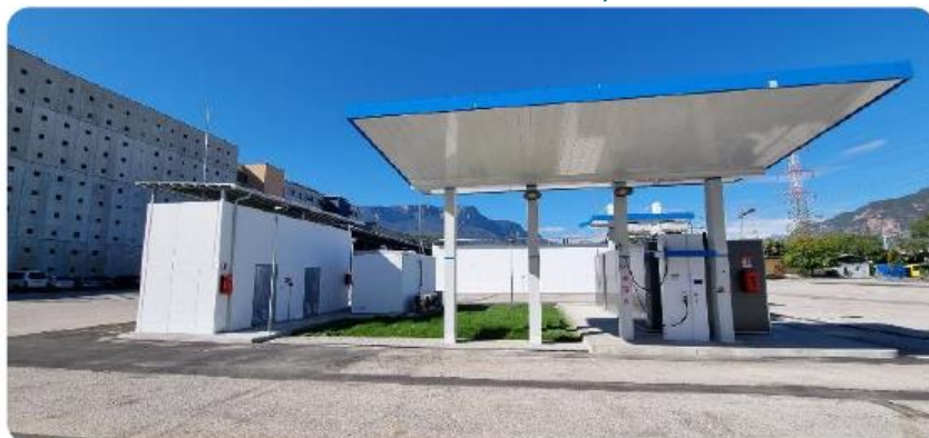
Wasserstofftankstelle in Bozen, Italien
