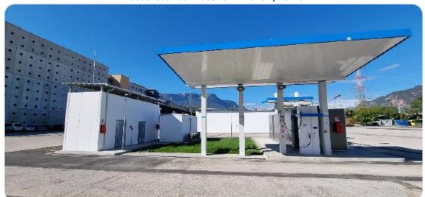
Wasserstofftankstelle in Bozen, Italien
